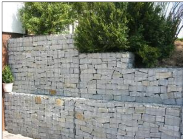
Gabione im Verbund (Quelle: Fa. Eiko)
